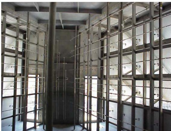
Նկ.1.21. V-ձև օդի մատուցման տրակտ
