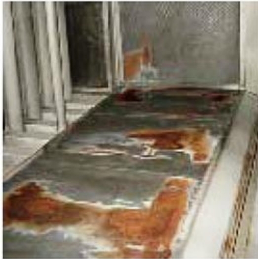
Նկ.1.36. ՊՏՏ օդի մատուցման տրակտի կոռոզիայի ենթարկված հատվածի տեսք
