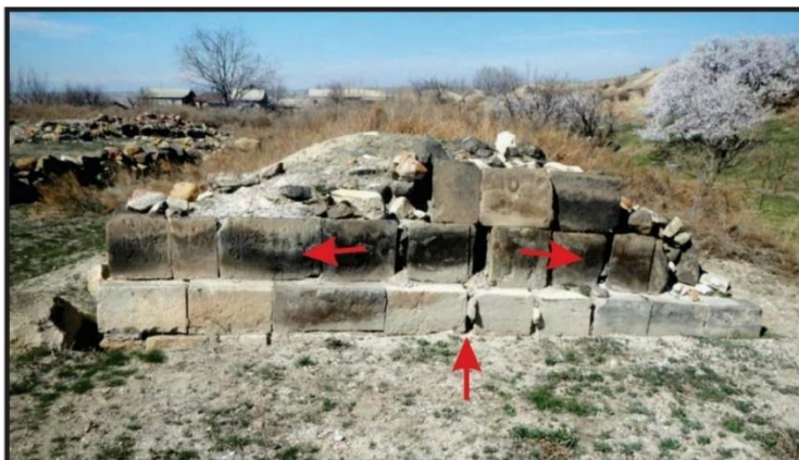
Рис.3.33. Эффект разжижения грунта (liquefaction) на участке центрального квартала города Двин.
