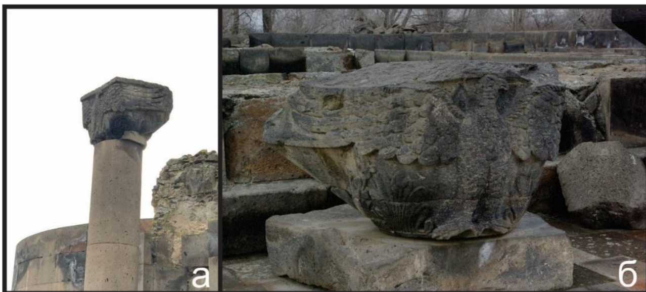
Рис.3.22. Следы сильного огня: а) на капители одной из восстановленных колонн; б) капитель с изображением почерневшего от копоти пожара орла.
