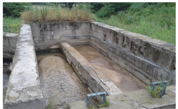
Նկ. 1.11. Կապան քաղաքի «Գյարդ» և Դիլիջան քաղաքի «Ֆրոլովի բակա» ջրընդունիչների մեծաբեկոր գլաքարերով և ավազատղմային նստվածքներով լցված ավազորսիչների տեսքը
