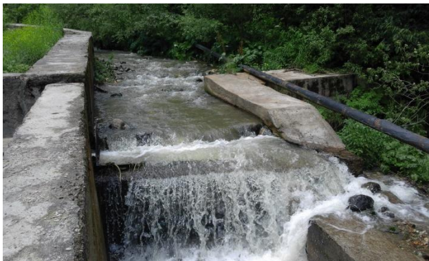
Նկ. 1.8. Դիլիջան քաղաքի «Ֆրոլովո բակա» և «Հանքային ջրեր» ջրընդունիչների պատվարային կառուցվածքների քայքայված տեսքը
