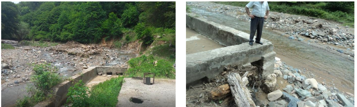
Նկ. 1.1. Գետի վարարումներից վնասված Բերդ քաղաքի «Տավուշ» ջրընդունիչի պատկերը
