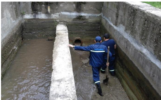
Նկ. 1.12. Դիլիջան քաղաքի «Ֆրոլովի բակ» ջրընդունիչի լցված ավազորսիչների նստվածքներից մաքրման աշխատանքների պատկերը
