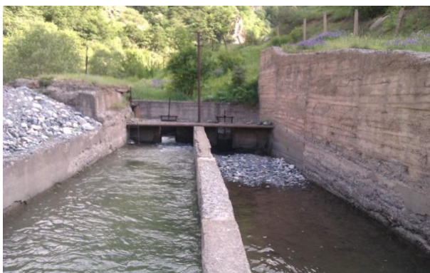
Նկ. 1.11. Կապան քաղաքի «Գյարդ» և Դիլիջան քաղաքի «Ֆրոլովի բակա» ջրընդունիչների մեծաբեկոր գլաքարերով և ավազատղմային նստվածքներով լցված ավազորսիչների տեսքը
