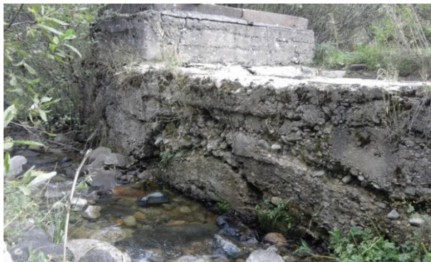
Նկ. 1.5. Վանաձոր քաղաքի «Սպիտակ ջուր» և «Ղադրի Ձոր N1» ջրընդունիչների կիսաքանդ պատկերը
