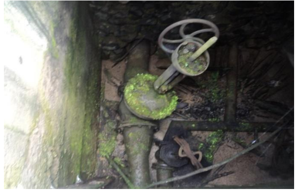
Նկ. 1.13. Ավազորսիչների մուտքի և ելքի վրա տեղադրված հարթ և սեպավոր փականային հանգույցների պատկերը
