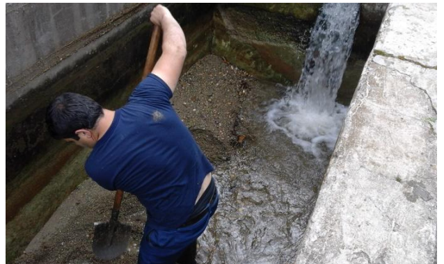
Նկ. 1.12. Դիլիջան քաղաքի «Ֆրոլովի բակ» ջրընդունիչի լցված ավազորսիչների նստվածքներից մաքրման աշխատանքների պատկերը
