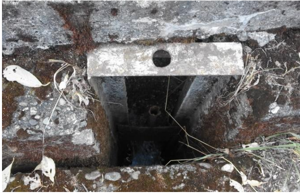
Նկ. 1.13. Ավազորսիչների մուտքի և ելքի վրա տեղադրված հարթ և սեպավոր փականային հանգույցների պատկերը
