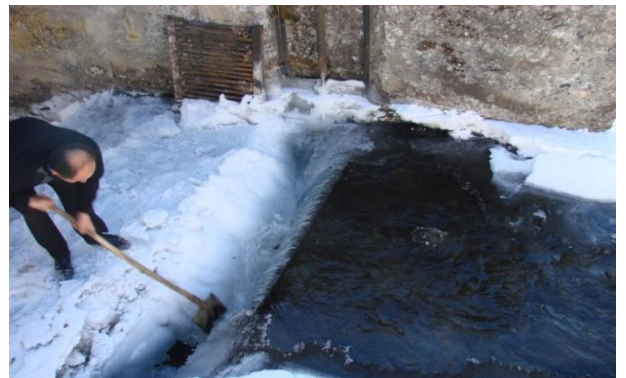
Նկ. 1.10. Դիլիջան քաղաքի «Ֆրոլովո բալկա» և Կապան քաղաքի «Չանախչի» ջրընդունիչների մեծաբեկոր քարերով խցանված և սառցակալված հատակային առվակների տեսքը
