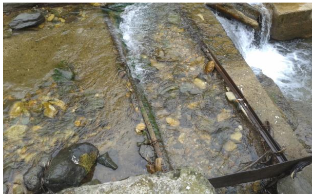
Նկ. 1.10. Դիլիջան քաղաքի «Ֆրոլովո բալկա» և Կապան քաղաքի «Չանախչի» ջրընդունիչների մեծաբեկոր քարերով խցանված և սառցակալված հատակային առվակների տեսքը
