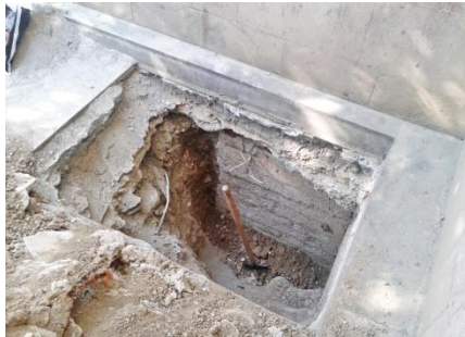
Նկ. 2.2. Ավիացիոն ինստիտուտի ճաշարանի հիմքերի հետազոտման համար բացված հետախուզահորեր
