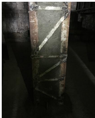
Նկ. 4.1 Մեխանիկական հարվածից վնասված սյուն ա) վնասված վիճակում, բ) վերականգնումից (ուժեղացումից) հետո:
