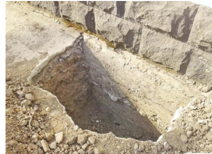
Նկ. 2.2. Ավիացիոն ինստիտուտի ճաշարանի հիմքերի հետազոտման համար բացված հետախուզահորեր
