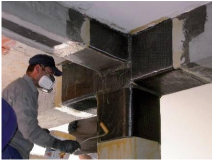
Նկ. 3.40 երկաթբետոնե հանգույցի ուժեղացման ընթացքը
