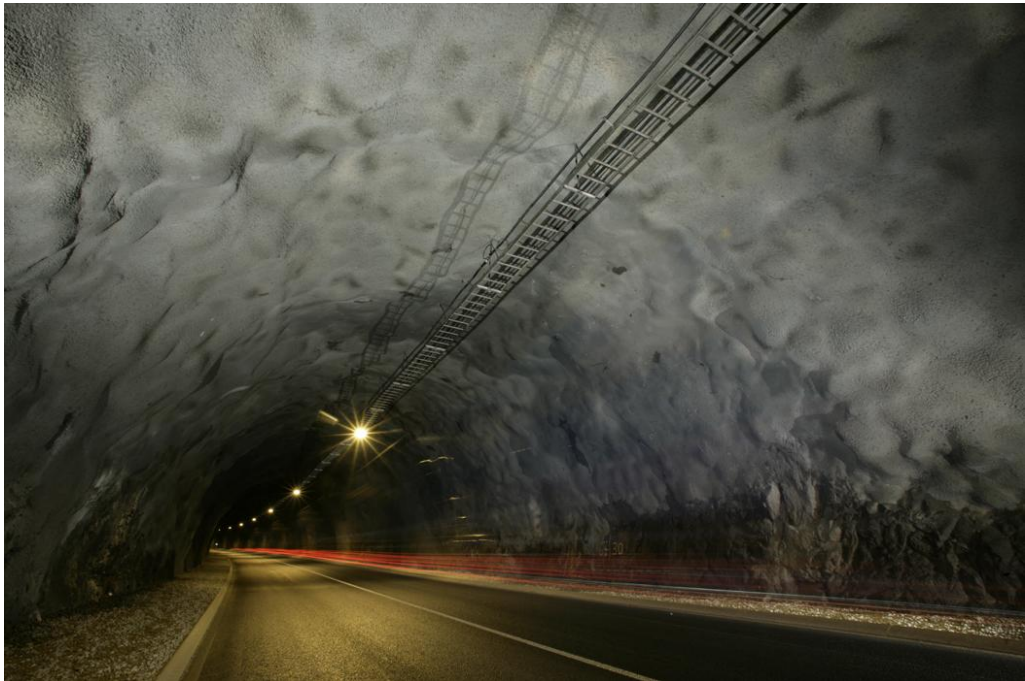
Նկ.1.5 Փչ ովի մեմբրանի կիրառմամբ ջրամեկուսացման օրինակ
