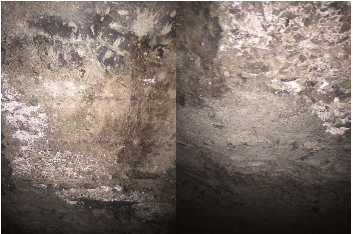
Նկ. 4.5 Սևան-Դիլիջան ավտոմոբիլային թուղնեղի երեսարկը փորձարկվող ջրամեկուսացման եղանակի կիրառումից երեք շաբաթանց
