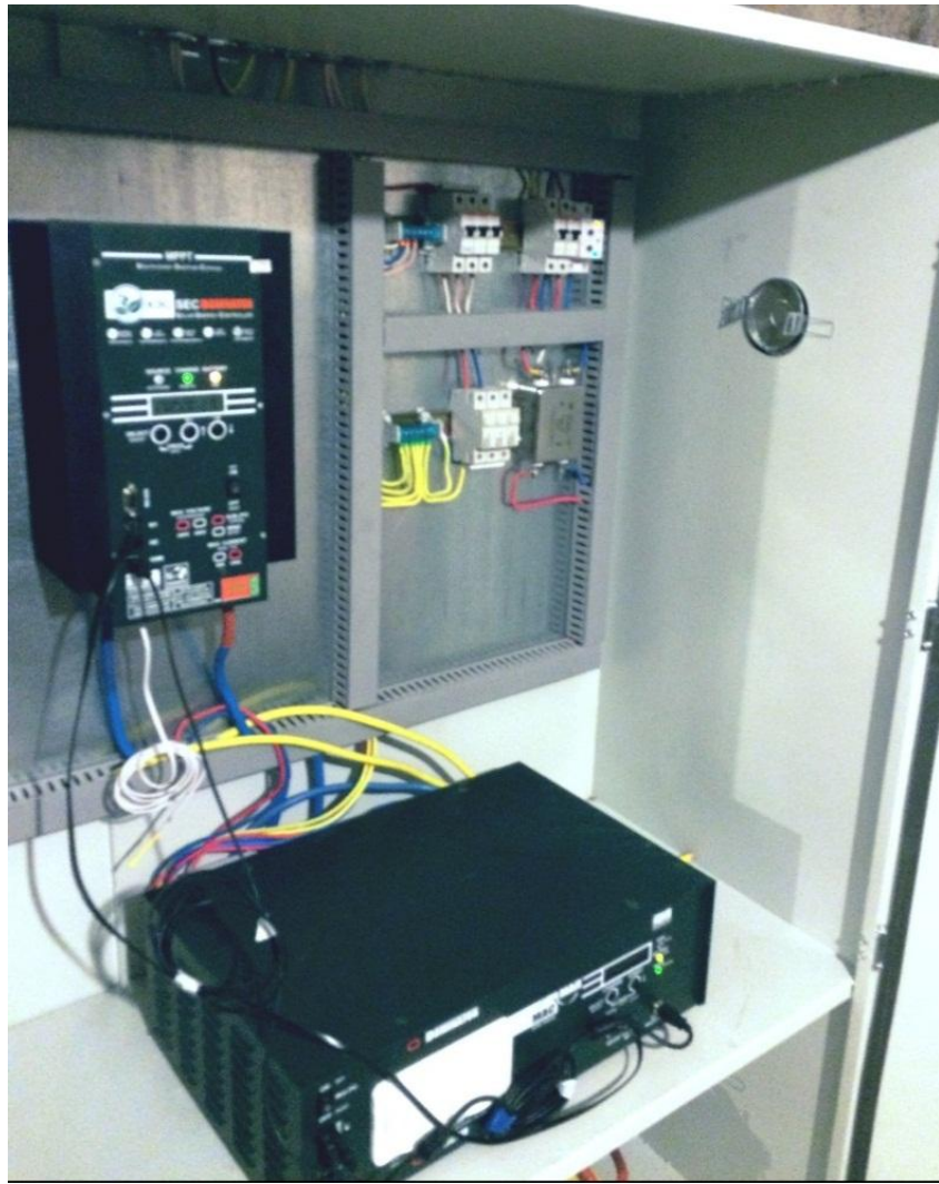
Նկ. 3.3.2. Տեղակայված ֆոտոէլեկտրական կայանի կարգավորիչը և ինվերտորը
