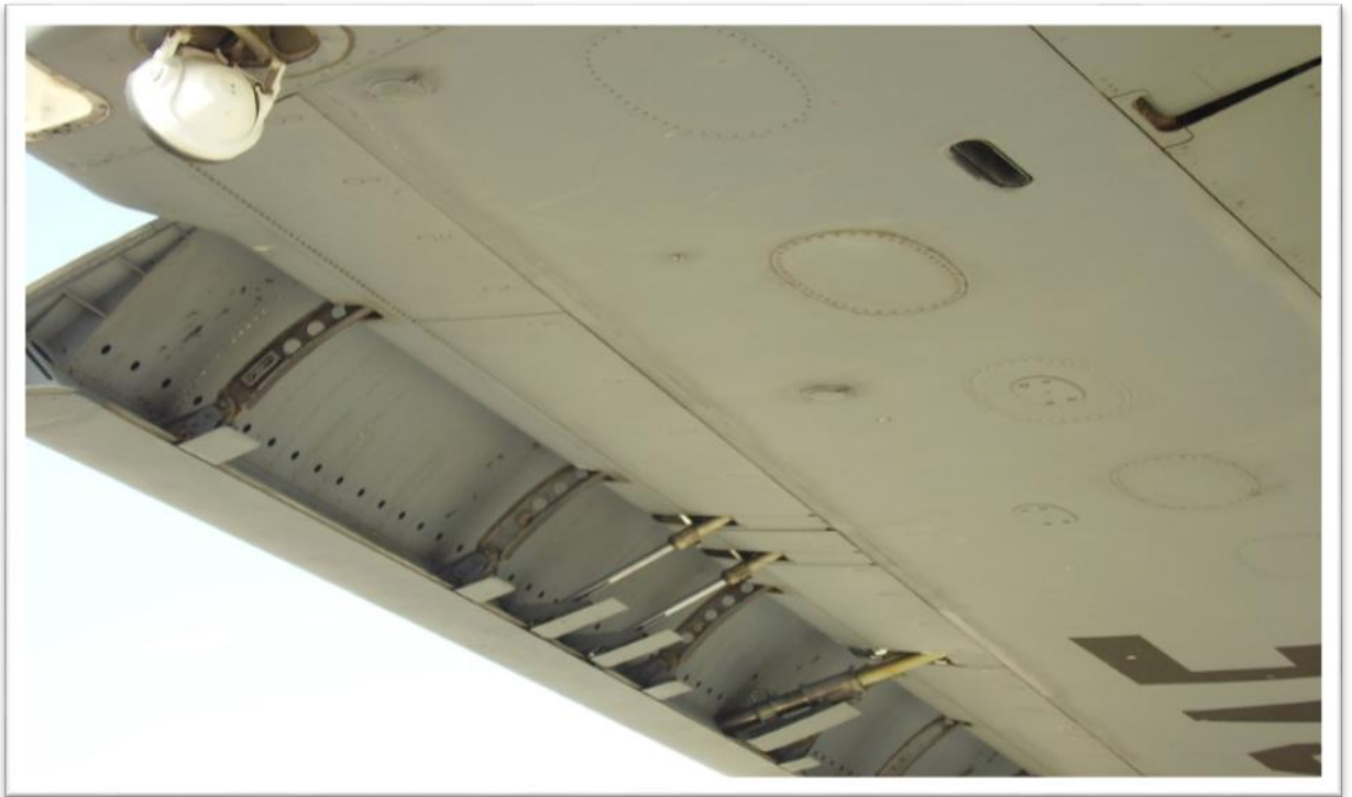
Рис. 2.3.2. Установка агрегатов механизации крыла и технических люков
